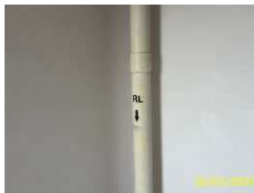
ท่อระบายเสียและน้ำฝน
